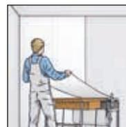
**2b.** на обои с помощью клеенамазочного станка. Обои не требуют пропитки.
