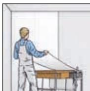
**2а.** Оклеивать с помощью клеенамазочного станка без пропитки или
